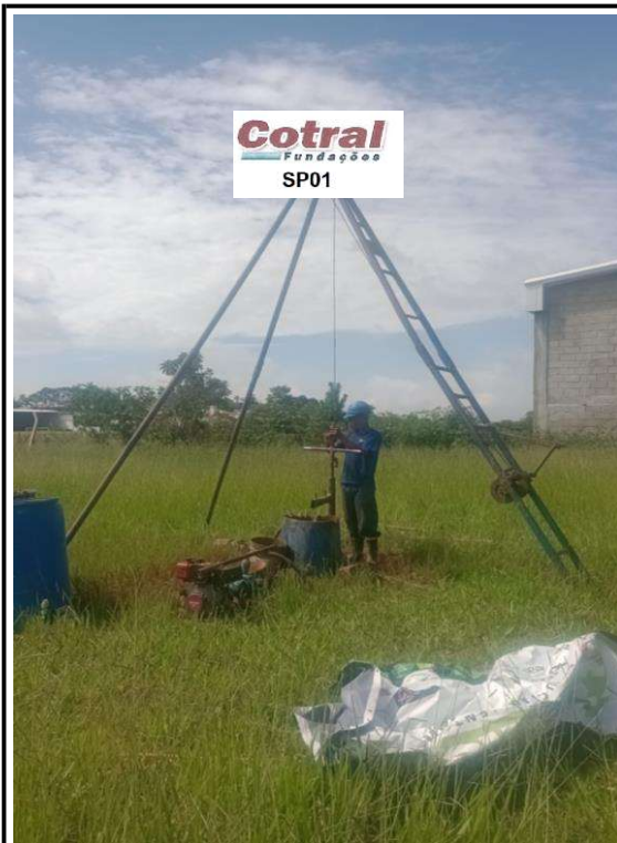
Foto 1 - Equipamento de Sondagem em Operação
