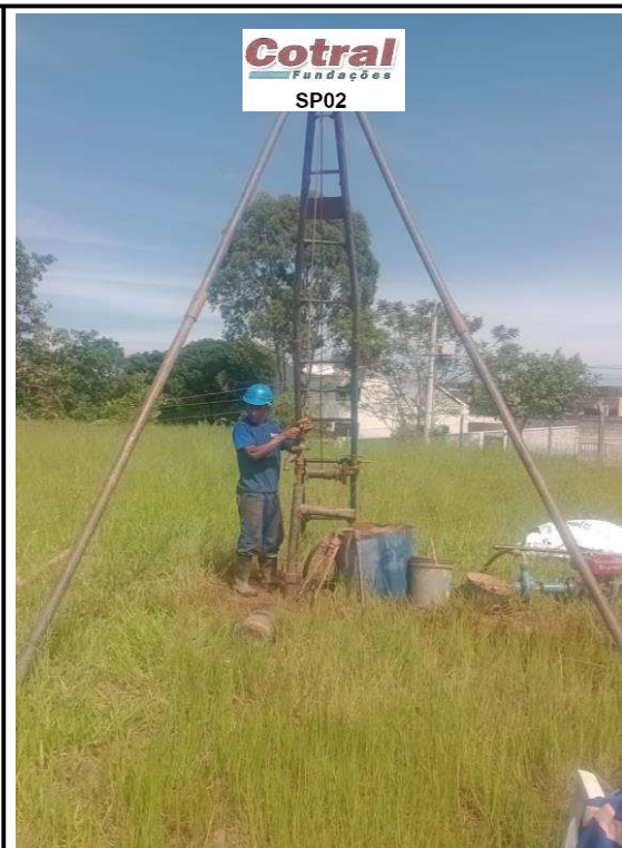
Foto 2 - Equipamento de Sondagem em Operação
