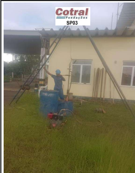
Foto 3 - Equipamento de Sondagem em Operação
