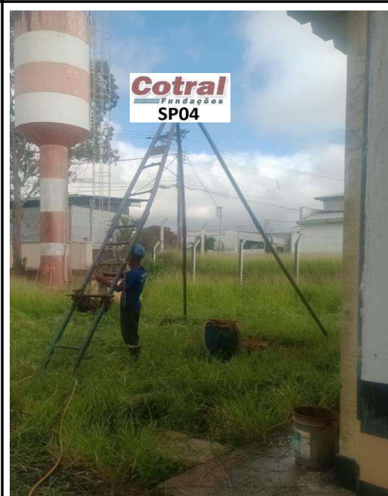
Foto 4 - Equipamento de Sondagem em Operação
